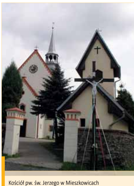
Kościół pw. św. Jerzego w Mieszkowicach
